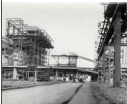
Строительство установки сухого тушения кокса
